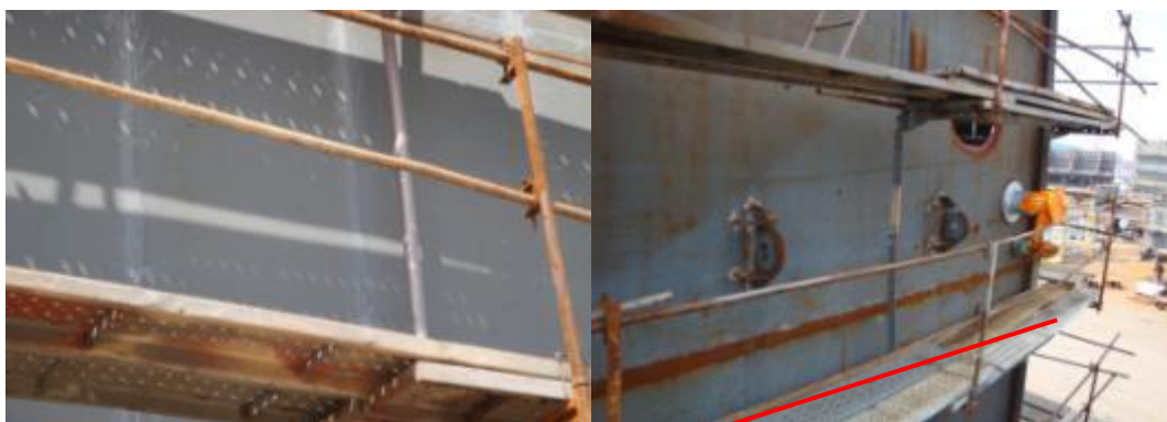
火工区域锈蚀状态
