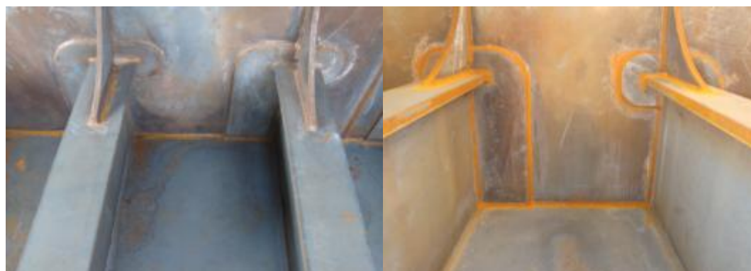
焊缝锈蚀状态
